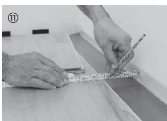
Tagliare e adattare gli elementi dell'ultima fila sul lato lungo tenendo conto di una distanza di dilatazione di 10-15 mm.
