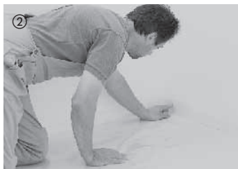
Essenzialmente, sulla caldane e in caso di posa con riscaldamento a pavimento è necessario utilizzare un foglio di polietilene dello spessore di 0,2 mm e sovrapporlo di 30 cm nell'area di giunzione. Successivamente il foglio va sollevato lungo la parete e tagliato lungo il bordo superiore dopo il montaggio del battiscopa.
