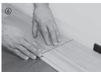
Gli altri elementi della prima riga vanno incastrati dall'alto con le estremità della tavola nella tavola precedente. Premendo brevemente sul giunto orizzontale, l'elemento scatta in posizione nell'elemento adiacente. Occorre prestare attenzione all'esatto allineamento degli elementi. Tagliare e inserire l'ultimo elemento della prima fila, considerando una distanza di dilatazione di 10 - 15 mm verso la parete.
