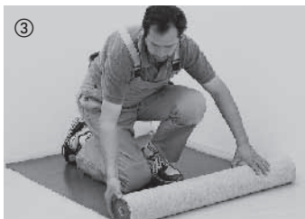
Per isolare rumori da calpestio e per compensare piccole asperità srotolare a livello un pannello comfort fonoassorbente spesso 2 mm. Nella nostra gamma di accessori potete trovare varie tipologie di basi isolanti. Il cartone bitumato non è adatto per isolare rumori da calpestio. Il parquet con base isolante rivestita non è idoneo per l'incollaggio sull'intera superficie.
