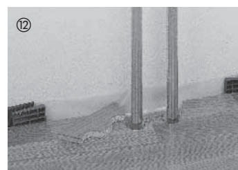
Per la condutture del riscaldamento che spuntano dal pavimento, trapanare i segare aperture negli elementi (dimensioni in relazione allo rispettivo tubo di riscaldamento e tenendo conto della distanza di dilatazione necessaria).
