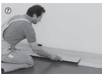
Ricominciare con la fila successiva utilizzando il pezzo rimanente della prima fila (elementi sfalsati di almeno 50 cm). In questo modo si riducono notevolmente gli scarti. Proseguire con la posa elemento per elemento. A questo scopo, con una lieve pressione, ruotare prima longitudinalmente gli elementi nel collegamento.
