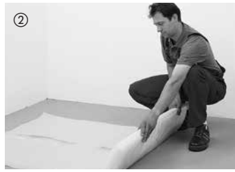
En règle générale, il faut toujours poser un film en polyéthylène de 0,2 mm d'épaisseur sur toutes les chapes et lors d'une pose sur un chauffage au sol. Les raccords des feuilles doivent se chevaucher sur environ 30 cm. Relever la feuille sur le mur et la couper, après le montage des plinthes, sur l'arête supérieure de ces dernières.
