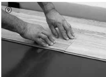
La lame est abaissée à l'about. Veillez à cet égard que la lame soit glissée sur l'about aux abords de l'arête de la lame posée précédemment. En appuyant légèrement sur le chant transversal, la lame s'enclenche.
