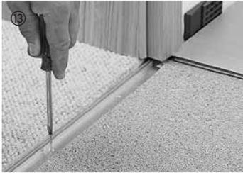
A fin de guardar la distancia hacia los bordes, debe ser instalado un sistema de perfil en transiciones de puerta. Al efectuar una instalación „continua„ a un recinto lindante, se requiere una junta de separación. Ésta debe ser dotado de un perfil de transición.
