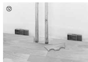
⑫ Para los tubos de calefacción salientes del suelo, son talatrasas o cortadas aberturas en los elementos (tamaño en función del respectivo tubo de radiador y bajo consideración de la distancia de dilatación requerida).
