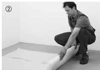
② Es necesario extender una lámina de PE de 0,2 mm de grosor en todos los solados y al efectuarse la instalación sobre calefacción de suelo radiante, debiendo solaparse 30 cm en la zona de unión. A continuación, levantar la membrana por la pared y, tras la instalación de los zócalos, cortarla a ras con el borde superior de éstos.
