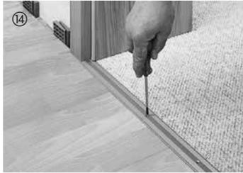
El carril debe ser guardada una distancia de dilatación de 5 mm. Básicamente deben ser cortados marcos de puerta de madera al grosor de los elementos empleando una sierra fina, a fin de que el suelo laminado pueda dilatarse. Retirar las cuñas distanciatoras tras la instalación del suelo. Fijar los zócalos (con sistema de clip o sin él) a la pared y...listo.
