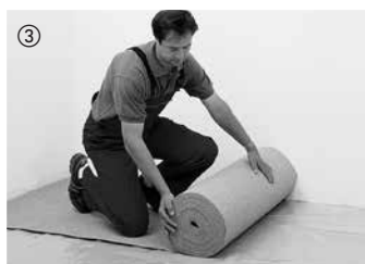
③ Til trinlydisolering og til udligning af mindre ujævnheder udrulles et 2 mm tykt lyddæmpningsunderlag af kork uden buler. Se også andre lyddæmpningsunderlag i vort tilbehørstilbud. Asfaltpap er ikke egnet til trinlydisolering. Ved HARO laminatgulv med Silent Pro® må der ikke anvendes yderligere isolering.
