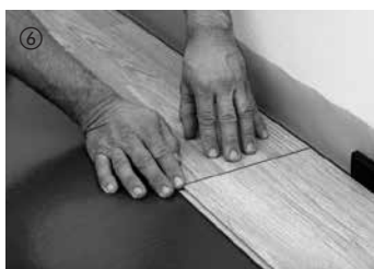
⑥ De øvrige elementer i første række skal klikkes ind oppefra i det forrige bræt ved hovedenderne. Ved et kort tryk på tværsamlingen klikker elementet ind i det tilstødende element. Vær opmærksom på, at elementerne flugter nøjagtigt. Det sidste element i første række tilskræres og indsættes, idet der tages højde for en ekspansionsafstand på 10 -- 15 mm til væggen.
