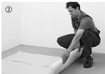
② Ved alle cementgulve og ved udlægning på gulvvarme skal der principielt lægges en 0,2 mm tyk PE-folie, som skal overlappe 30 cm i kanten. Folien trækkes op ved væggen og skæres efter monteringen af fodlister af ved overkanten af disse.
